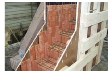
3. Konstrukcja szalunku do wykonania gzymsu
