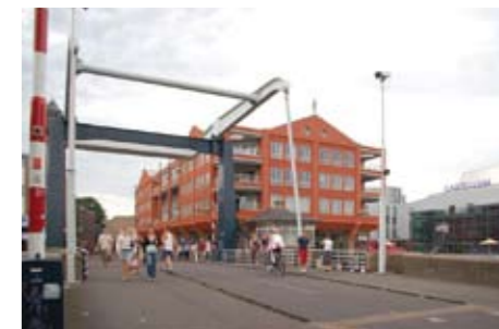
14. Gotowy budynek - widok z mostu
